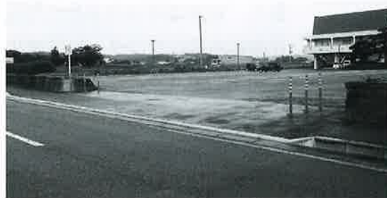
改修工事が完了し、門口が広くなりました。
