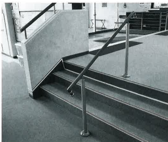
1階ロビーの段差に手すりを設置
